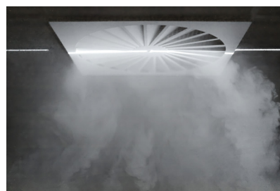
Obr. 1: Prívod teplého vzduchu (> 22°C)
